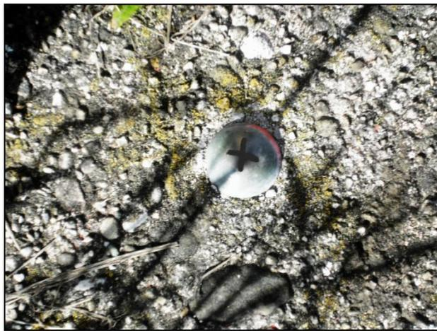
**Abbildung 4.2: Kennzeichnung der höchsten Stelle der Punkt-Marke (hier Stehbolzen)**
